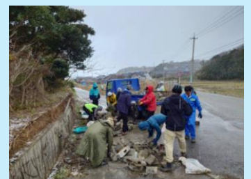
2024年3月ブロック塀の撤去作業
