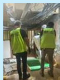
2024年8月取り壊し予定のホテルからの物資運び出し
